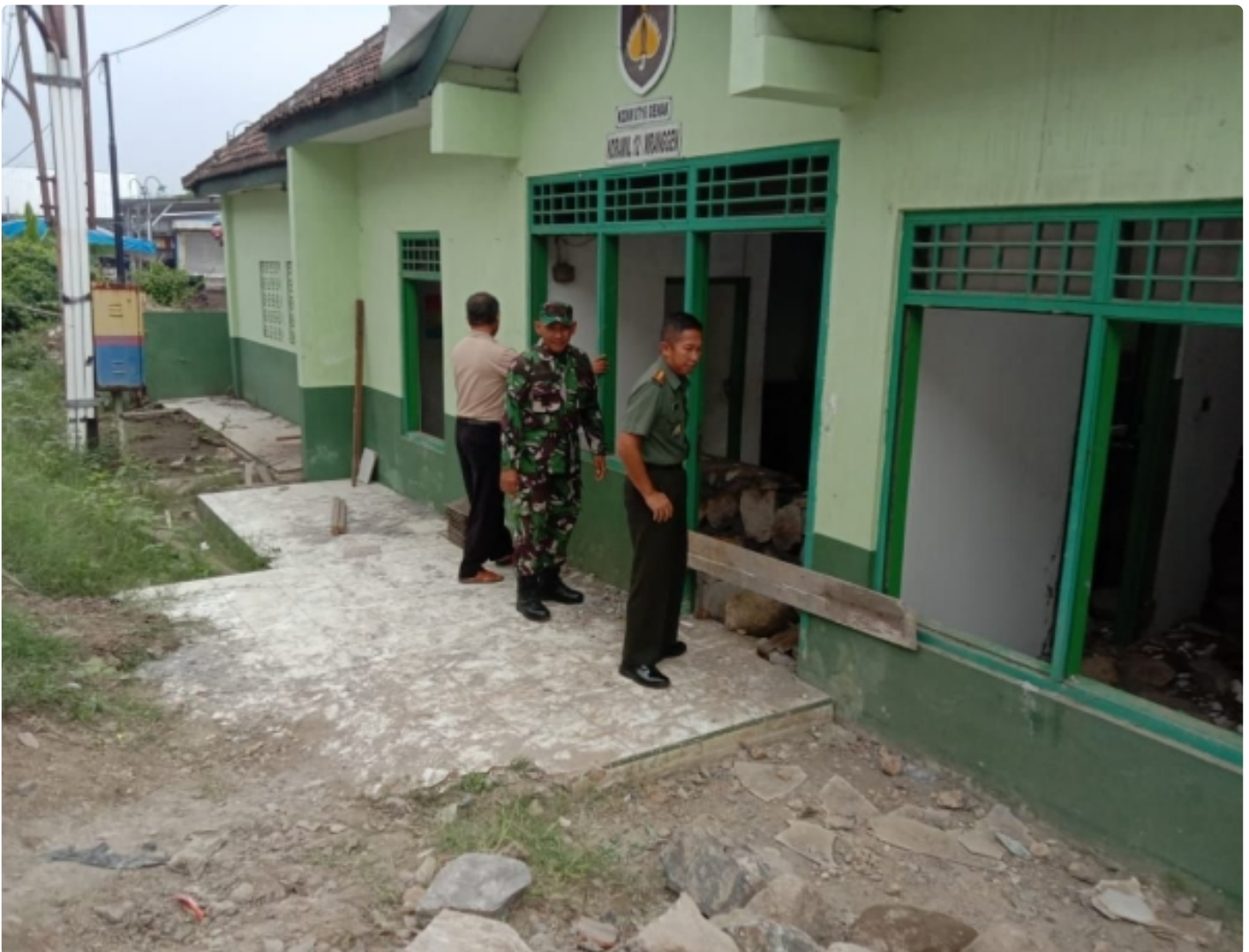
Kegiatan Dandim Demak Tinjau Pelaksanaan Renovasi Koramil 12/Mranggen
