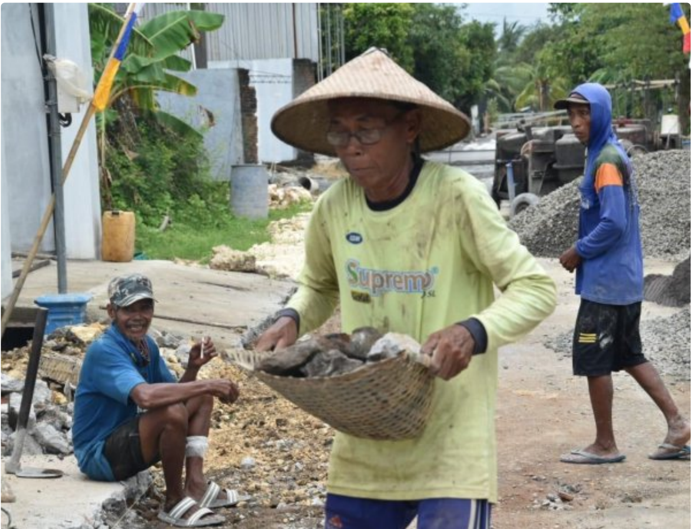
Mbah Triman saat mengangkat batu dilokasi TMMD
