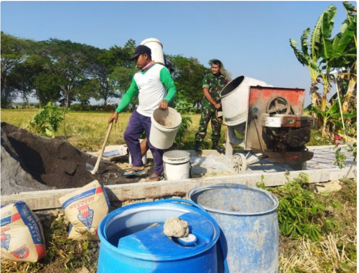
Menjadi Pelopor Diwilayah Binaan, Babinsa Gotong-Royong Bangun Jalan Desa.
