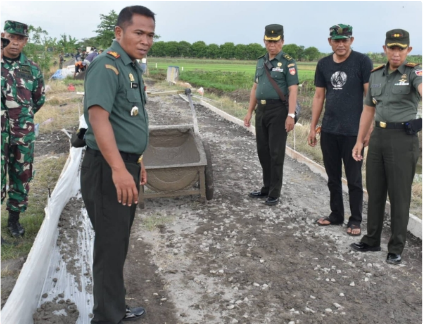
Giat Dandim Demak Saat Tinjau Lokasi TMMD Di Desa Rejosari
